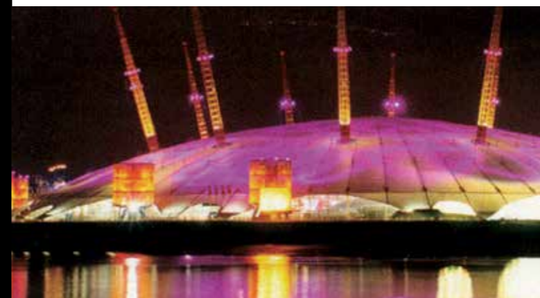
La iluminación teatral y de animación de la cúpula está controlada por el sistema de control DynaLite.
