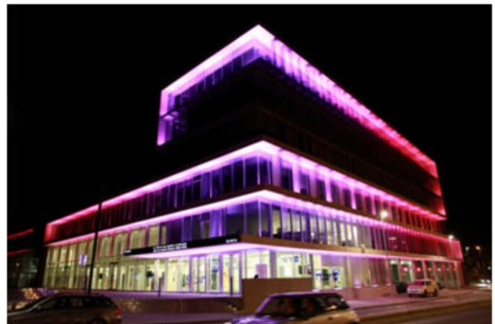
Des Philips ColorGraze ont été utilisées pour réaliser ce projet. Les ColorGraze sont des barreaux LED RGB qui permettent de contrôler la lumière par zone de 30cm. Grâce au système de gestion DMX, il est ainsi possible de faire varier la couleur du bâtiment dans son ensemble mais également de contrôler individuellement chaque zone pour un nombre infini de possibilités.
