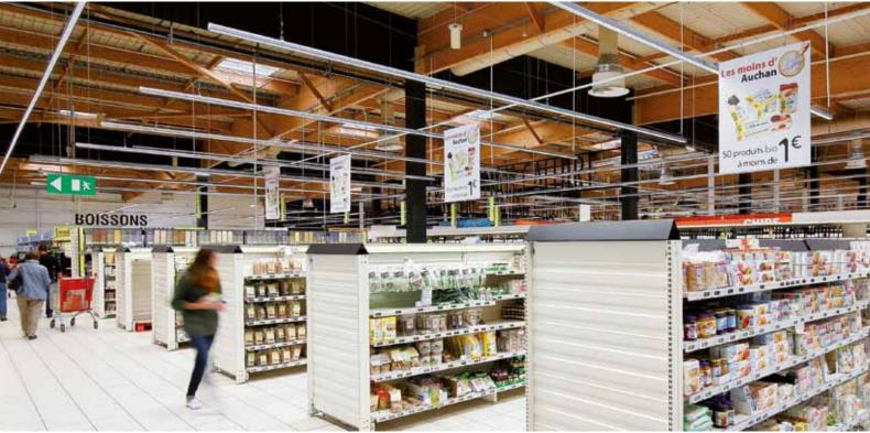
Des lignes lumineuses discrètes, jusqu'à 100 m de long, installées à 3,80 m du sol, réalisées avec des luminaires Maxos LED HE qui offrent une efficacité lumineuse de 135 lm/W. En tout, près de 5 km de rails lumineux et 280 000 LED.
