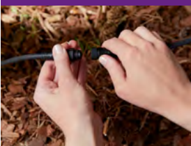
El cable de alimentación de 40 W permite la configuración básica bajo voltaje
