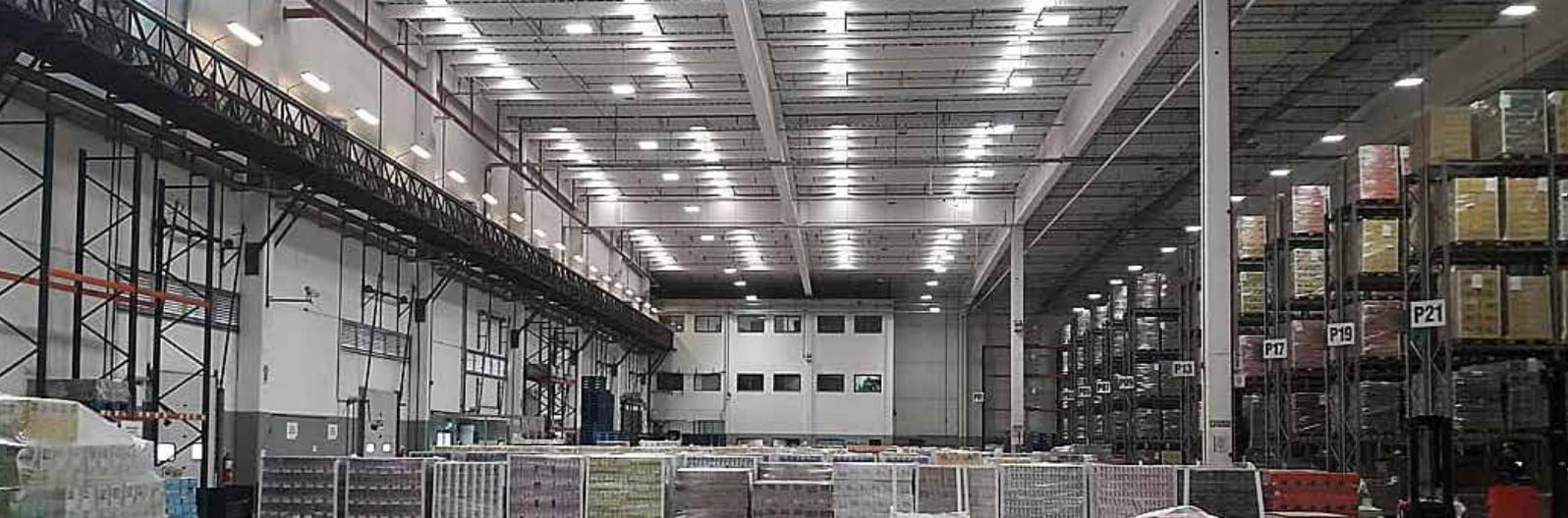
Para alcanzar las metas de eficiencia energética planteada el equipo de Casa Magnani SRL en conjunto con Signify definió instalar luminarias Philips GreenUp Highbay G2 BY560X, con tecnología SpaceWise, que integran sensores inteligentes de sensado de presencia o luz natural, incluso en naves de hasta 16 metros de altura, permitiendo la configuración de distintas escenas para maximizar el ahorro energético y el confort para los empleados.
