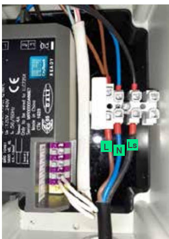
Figure 4 : raccordement du boîtier de commande
