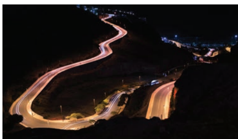
Un éclairage avec optiques adaptées
