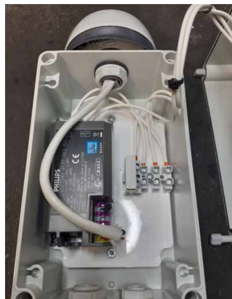
Figuur 2: Binnenkant kastcontroller met communicatienode direct op de box gemonteerd (alleen voor montage buiten)
