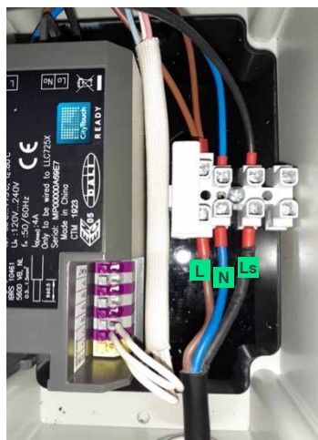
Figuur 4: Aansluiten van de kastcontroller
